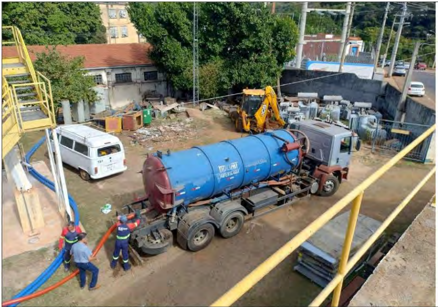
Foto 12 – Carregamento visto do topo do decantador (03/Ago/2024).
