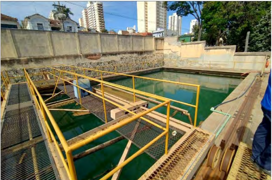
Foto 21 – Final do Decantador 01 da ETA1. Atrás do muro está a Rua Luiz de Queiroz e a Praça Boyes (árvores) (03/Ago/2024).
