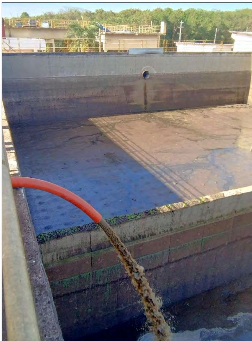
Foto 30 – Efluente transferido da EEE para o decantador da ETE (03/Ago/2024).
