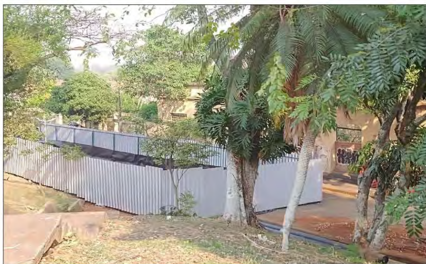
Foto 42 – Local onde serão instalados os BigBags, visto em 05/Set/2024.
