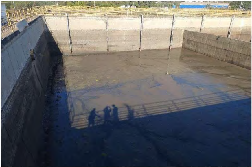
Foto 24 – Vista do decantador, a partir do topo do reservatório (03/Ago/2024).
