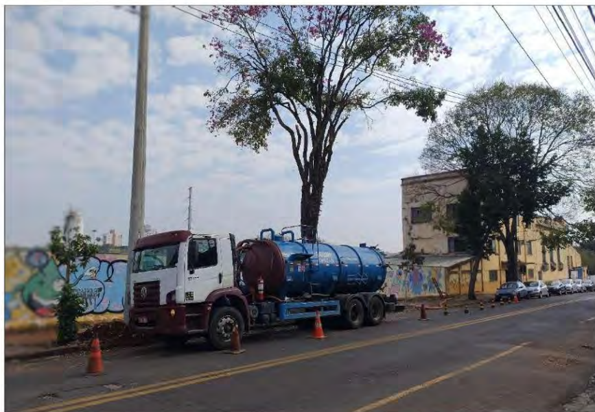
Foto 34 – Bombeamento dos decantadores da ETA1, com caminhão-tanque à vácuo, a partir da Rua Luiz de Queiroz, em 29/Ago/2024.
