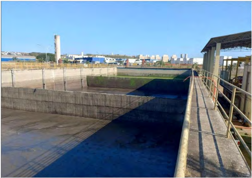
Foto 25 – Vista do decantador, mostrando a divisão interna em três sub-tanques (03/Ago/2024).
