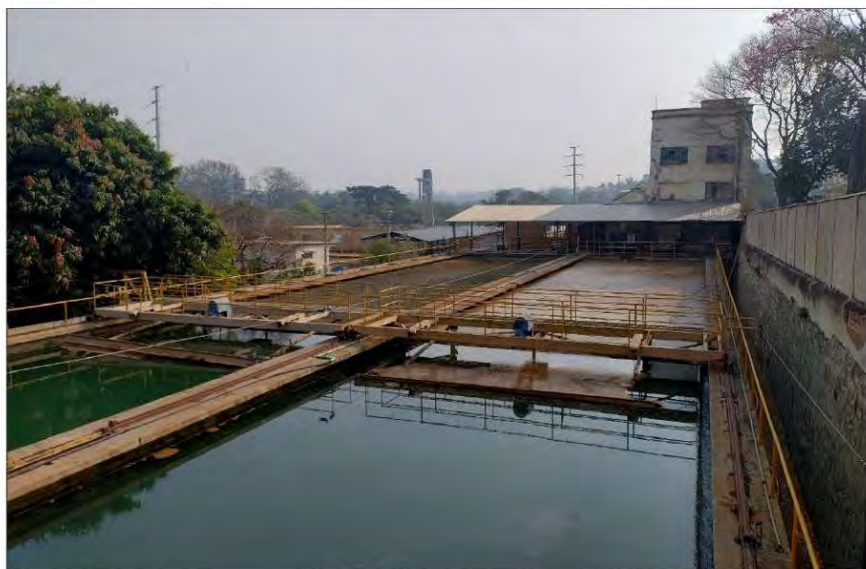
Foto 40 – Vista dos decantadores de ETA1, em 05/Set/2024.
