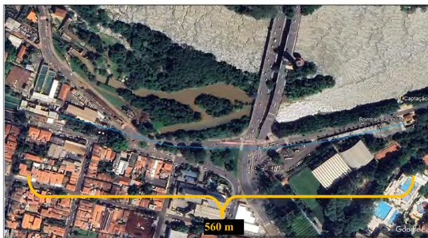
Figura 2 – Captação de água no Rio Piracicaba, a montante da Ponte do Mirante, distando cerca de 560 m da Estação de tratamento. A linha azul indica o provável caminhamento da Adutora de Água Bruta, que leva a água captada até a Estação.
