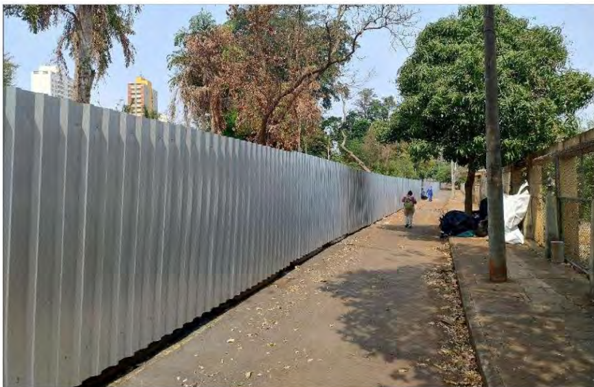
Foto 46 – Tapumes isolando a área de Bag's ao longo da rua em frente a antiga fábrica da Boyes, à direita na imagem (15/Set/2024).
