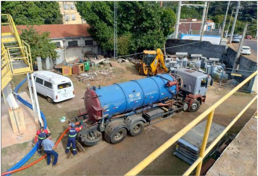
Foto 15 – Caminhão carregado por gravidade(03/Ago/2024).
