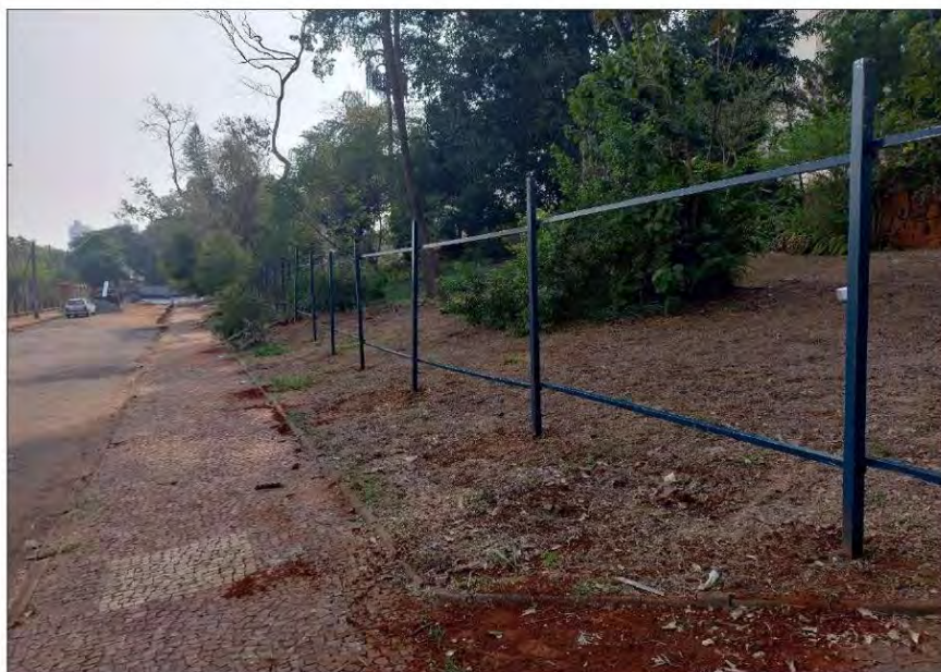
Foto 43 – Local onde serão instalados os BigBags. Isolamento da área, visto em 05/Set/2024.
