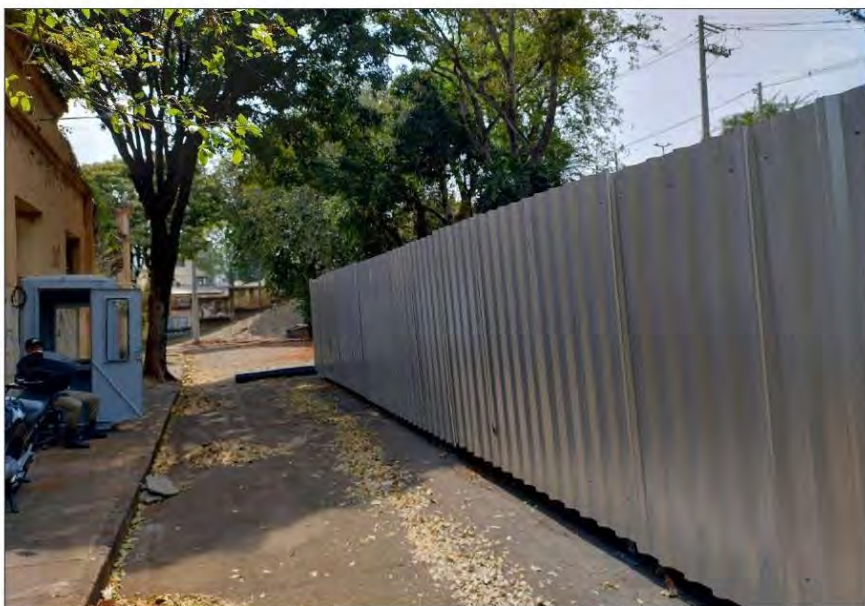
Foto 45 – Tapumes isolando a área de Bag's e guarita para vigilância 24hrs (15/Set/2024).
