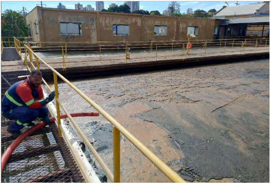
Foto 13 – Início da aspiração do material sobrenadante por vácuo (03/Ago/2024).
