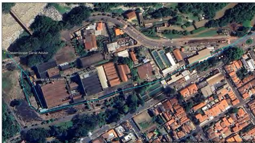
Figura 3 – Canal de Adução da Hidroelétrica da Boyes (azul claro), por onde ocorreu o despejo de resíduos da ETA no Rio Piracicaba. O Canal possui um bypass, à esquerda na imagem, para a água passar por fora das turbinas nos períodos de não geração.
