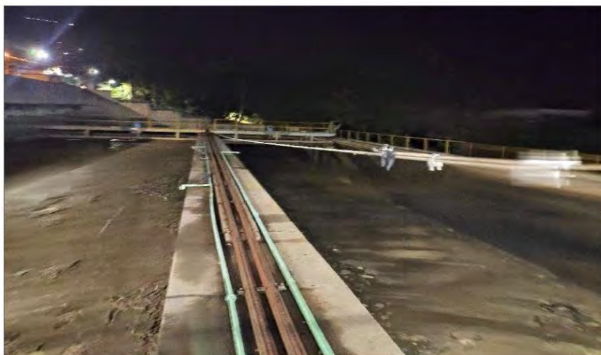
Foto 7 – Decantadores da ETA1. O decantador da direita foi esvaziado (noite de 22/Jul/2024).
