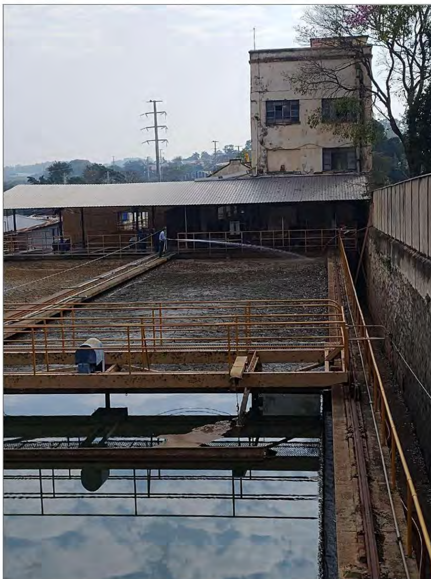
Foto 36 – Foi necessário realizar o desmonte hidráulico do material sobrenadante, acumulado na superfície do decantador 1 da ETA1, em 29/Ago/2024.
