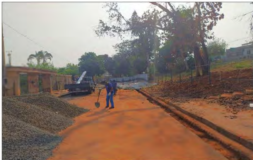
Foto 44 – Local onde serão instalados os BigBags. Início das obras, visto em 05/Set/2024.
