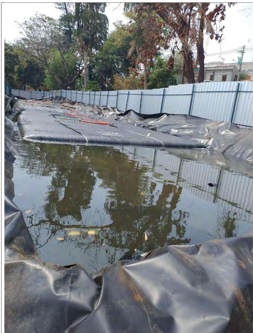
Foto 49 – Atrás do primeiro Bag, estão mais outros 3 Bag's, que serão preenchidos na sequência, de jusante para montante.
