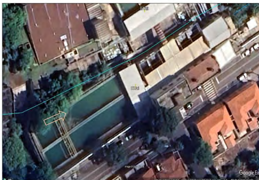
Figura 4 – Detalhe dos decantadores da ETA1 e do Canal de Adução da Hidroelétrica. O tanque 2 (seta) foi totalmente esvaziado na noite de 22 de Julho de 2024.
