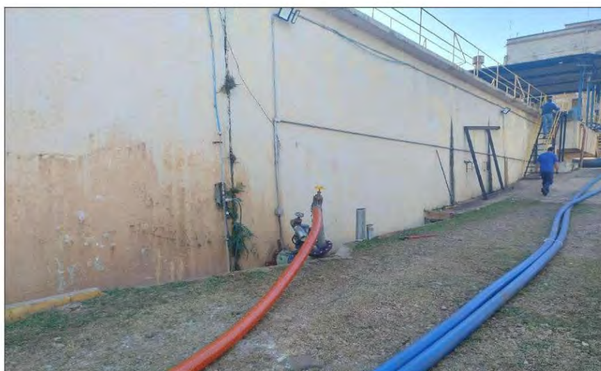
Foto 9 – Válvula adaptada como descarregador de fundo (03/Ago/2024).
