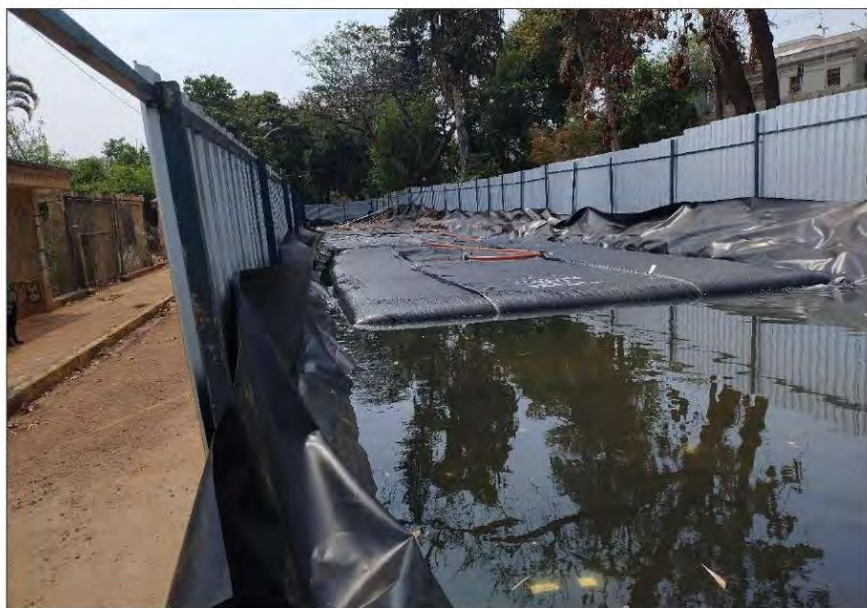
Foto 47 – Primeiro Bag em início de preenchimento.
