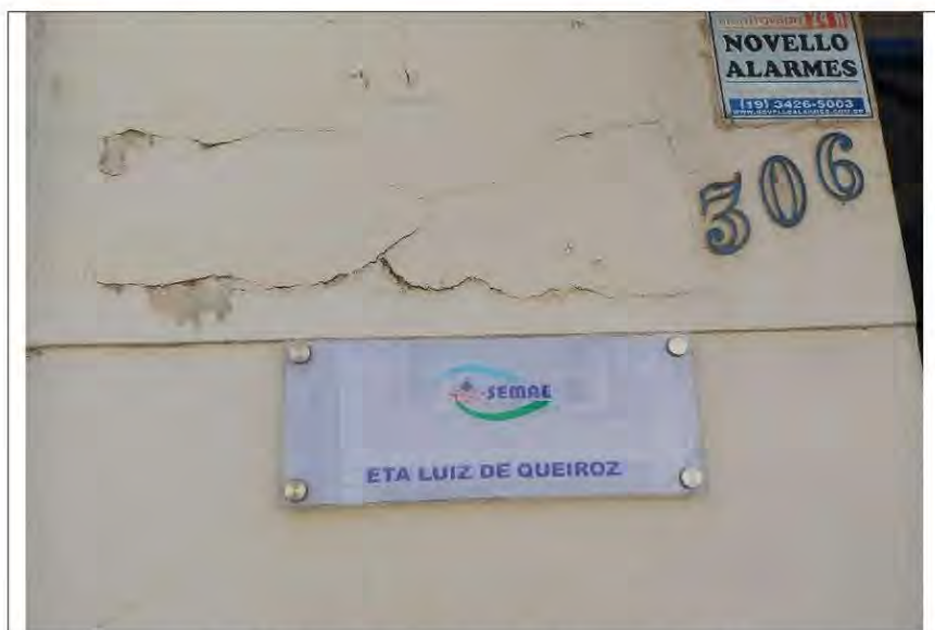
Foto 1 – Entrada da ETA Luiz de Queiroz – Rua Luiz de Queiroz, n.º 306, Centro, Piracicaba.
