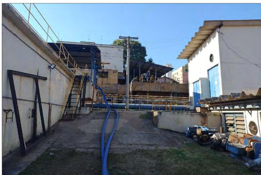
Foto 8 – Lateral da base do decantador da ETA2 (03/Ago/2024).
