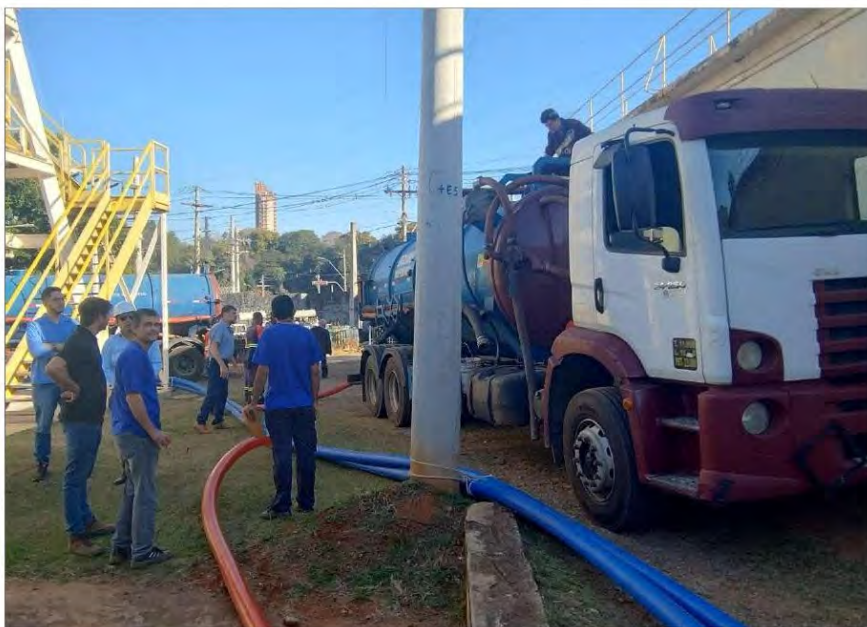
Foto 11 – Primeiro caminhão a ser carregado na base do decantador (03/Ago/2024).
