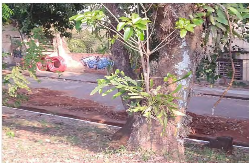
Foto 41 – Local onde serão instalados os BigBags, visto em 05/Set/2024. Início das obras.
