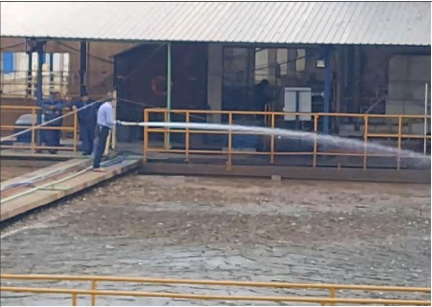
Foto 37 – Detalhe do desmonte hidráulico, em 29/Ago/2024.
