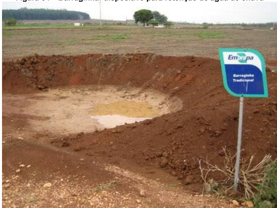
Figura 64 – Barraginha: dispositivo para retenção de água de chuva
