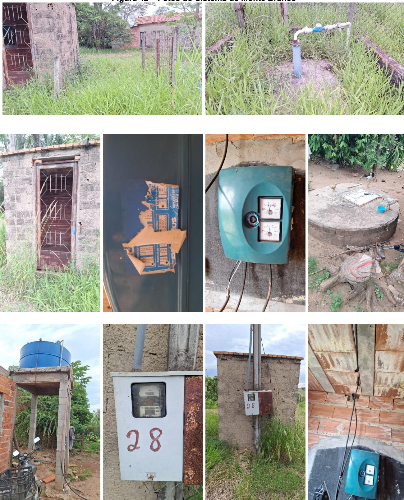
Figura 42 – Fotos do Sistema de Monte Branco
