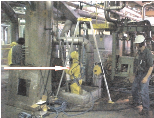
Foto 12 C: Operadores entrando no tanque para efetuar limpeza e inspeção em ambiente confinado (item 2.3.2) Detalhe: utilização de tripé para acesso e resgate
