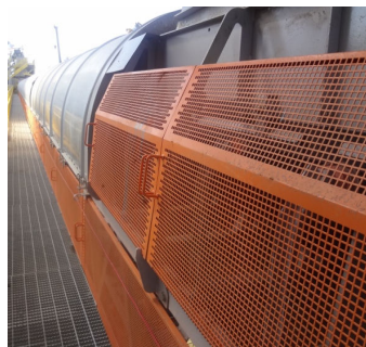
Foto 2 - Com a intervenção interinstitucional a empresa realizou as proteções das esteiras e atualmente utiliza novas tecnologias nas proteções das mesmas.
