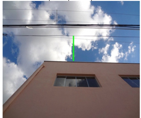
Figura 2 - Distância da rede para a parte superior do sobrado.
