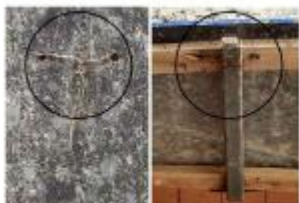
FIXAÇÃO POR ARAME: BWG N°18 OU SUPERIOR
