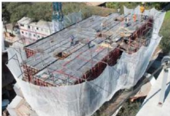
SLQA - PESADO MEDELO SECURITY REDE PARA-LIXO SOBREPOSTA P/ TELA FACHADEIRA MILIMÉTRICA ASSOALHAMENTO DE LAJE - VISTA EXTERNA
