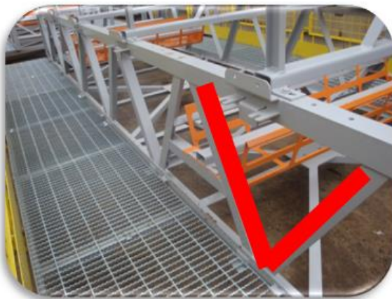
Foto 2. Montagem no chão
