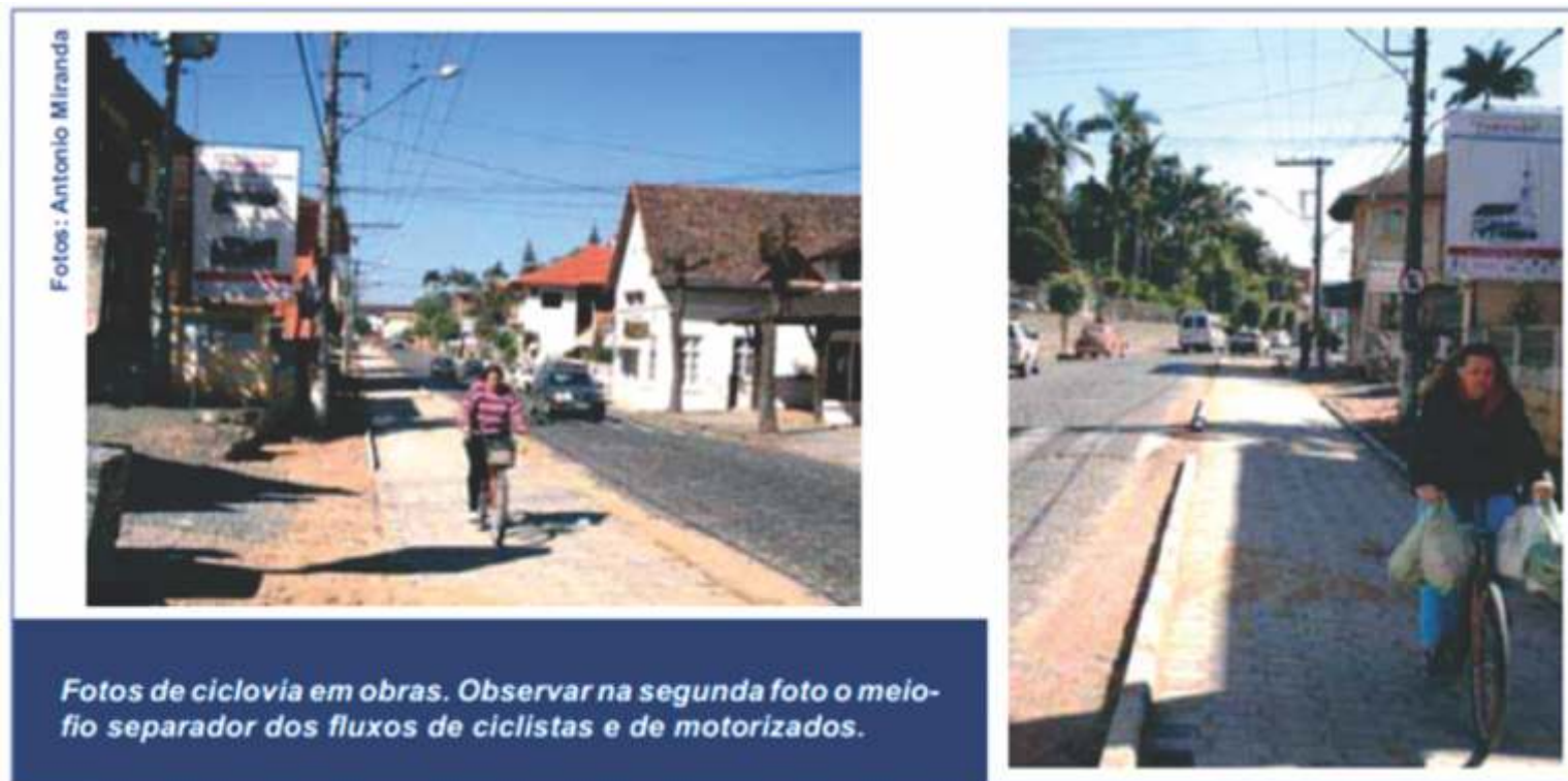
Flagrantes de ciclovia em construção, Pomerode-SC, 2006 Fonte: IB IDEM.
