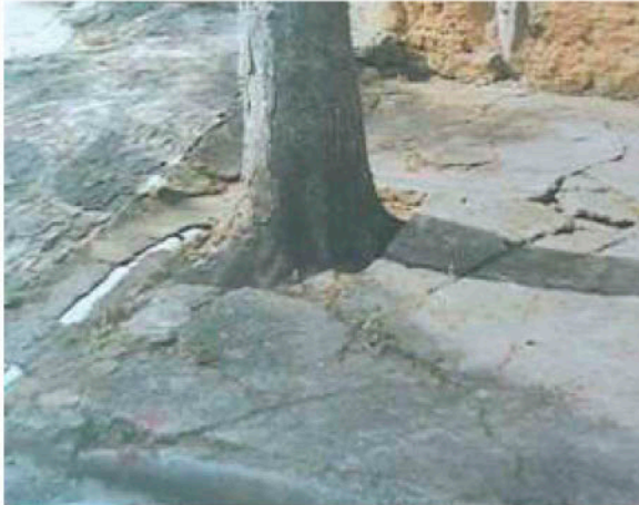
Fig. 15 – Fotografia demonstrando os problemas que um mau planejamento pode ocasionar na execução de calçada (interferência com rede de água pluvial e passeio público).
