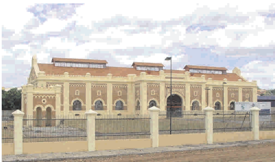
Fig. 10 - Antigo Matadouro Municipal recentemente restaurado para sediar a Empresa Municipal de Desenvolvimento Habitacional de Piracicaba - EMDHAP.
