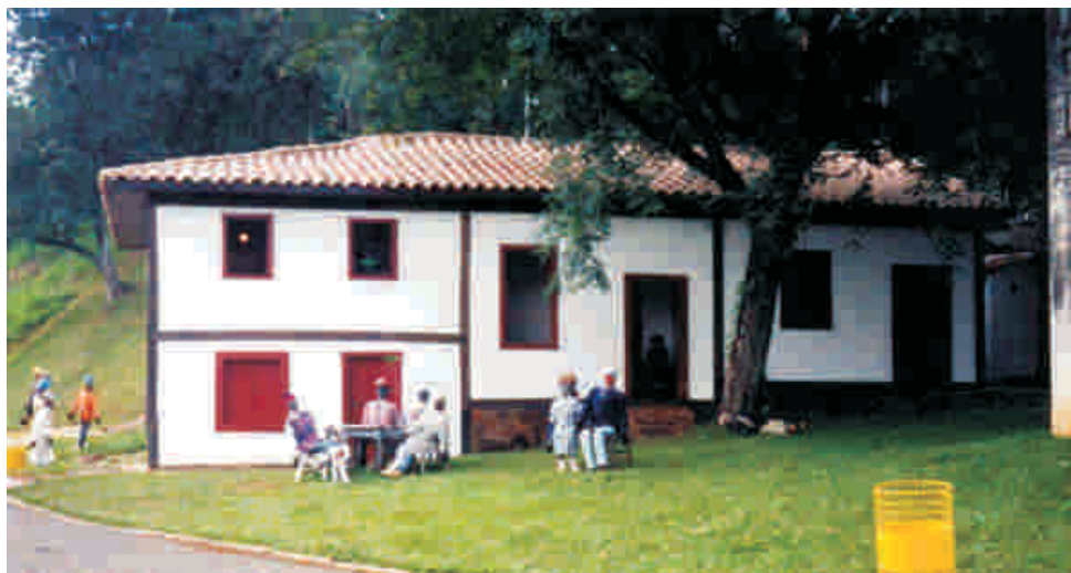
Fig. 03 - Casa do Povoador, uma das edificações mais antigas de Piracicaba. Tombada pelo CODEPAC e CONDEPHAAT.
