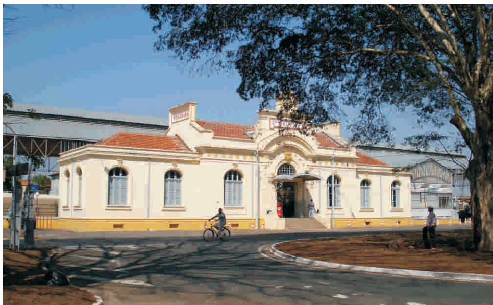
Fig. 07 - Antiga Estação da Cia. Paulista - Novousoapósrecuperação.
