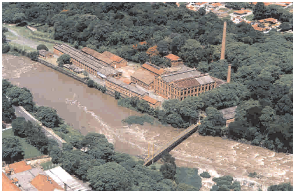
Fig. 01 - Vista do Parque do Engenho Central.
